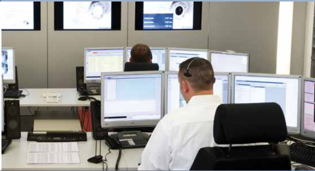
In der Notruf- und Serviceleitstelle von Protection One sichtet ein Mitarbeiterteam rund um die Uhr die eintreffenden Ereignisse.
