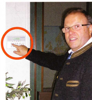
Nürlag-Geschäftsführer Alois Roth zeigt das Protection-One-System: Sofort das richtige Passwort eingeben – sonst wird Alarm ausgelöst
